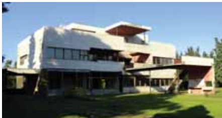
Volmanova vila v Čelákovících
