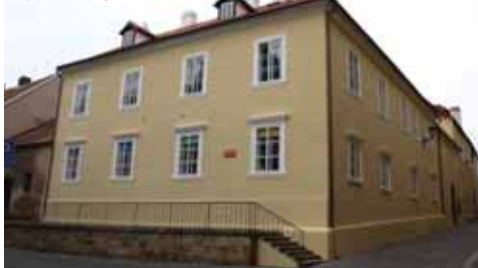
Zadní trakt domu č. p. 2, Valdštejnovo nám. (oprava fasády v r. 2014)
