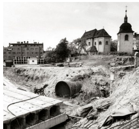
Fotografie z výstavby linky metra C s tunely vedoucími přímo pod kostelem. © Archiv Dopravního podniku hlavního města Prahy
