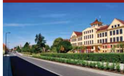
Opravená Boleslavská ulice
