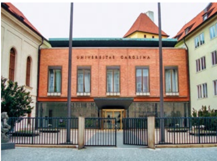
Karolinum, vstupní průčelí a čestný dvůr, současný stav
