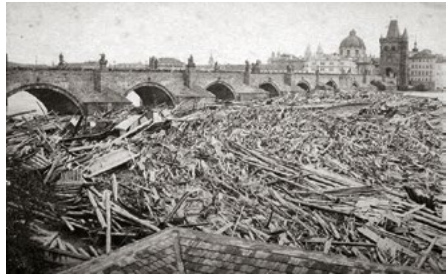
Povodeň 1872, Karlův most, Praha
