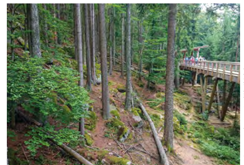
Vyhličková lávka s krytou částí
