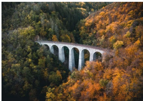
Žampašský most, železniční viadukt
