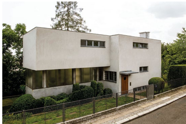
Citlivá rekonstrukce domu Palička
