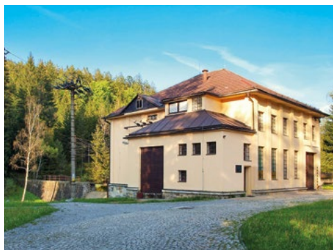
Budova elektrárny u nádrže pod Černým jezerem v osadě Hamry
