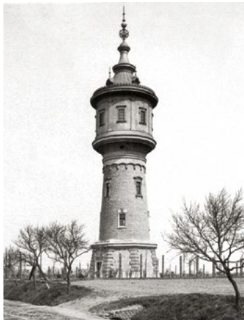
Libeňská vodárenská věž Mazanka, 1904
