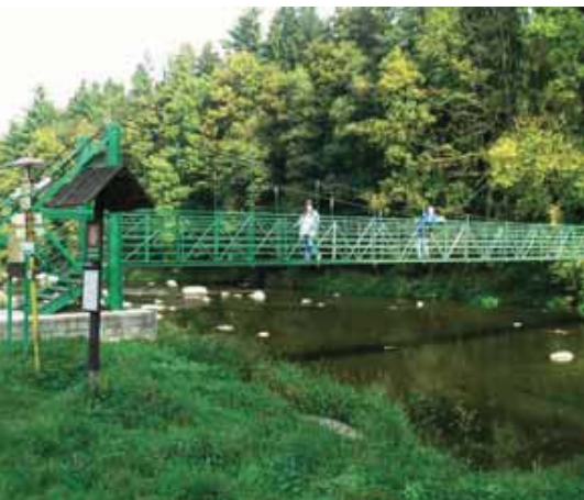
Most přes řeku Sázavu v lokalitě Stvořidla
