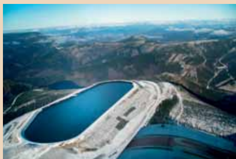
Přečerpávací vodní elektrárna Dlouhé Stráně
