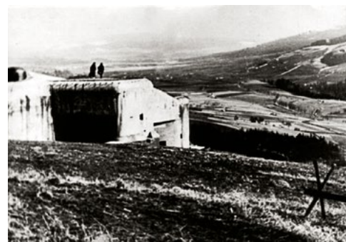
Pěchotní srub K-S 36 „Pod Adamem“
