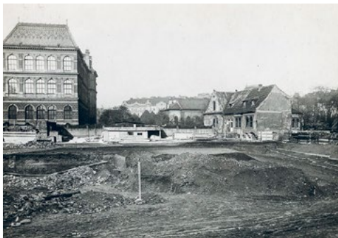
Hloubení základů pro stavbu Filozofické fakulty Univerzity Karlovy. Vlevo Uměleckoprůmyslové muzeum a vpravo Pinkasova synagoga po asanaci okolní zástavby. Foto Antonín Alexander, 1924. Archiv hlavního města Prahy, sbírka fotografií, sign. I 1525
