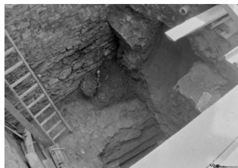
Západní část větší místnosti se zbytky někdejší klenby. Dole schody do lázně. Foto neznámého autora z roku 1968, archiv Národního památkového ústavu, územní odborné pracoviště v Praze
