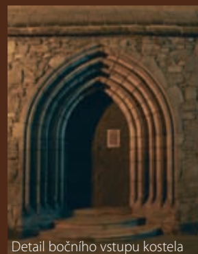
Detail bočního vstupu kostela
