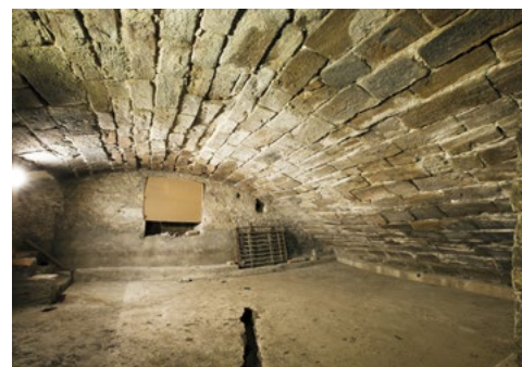
Kompletně dochovaný mostní oblouk Juditina mostu v suterénu domu č. p. 78. Foto M. Frouz, 2012 © Národní památkový ústav, územní odborné pracoviště v Praze
