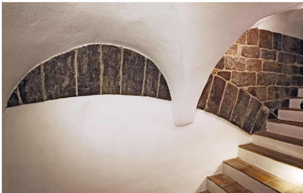
Severní bok Juditina mostu tvořený rozměrnými pískovcovými kvádry v suterénu domu č. p. 77. Foto M. Frouz, 2012 © Národní památkový ústav, územní odborné pracoviště v Praze
