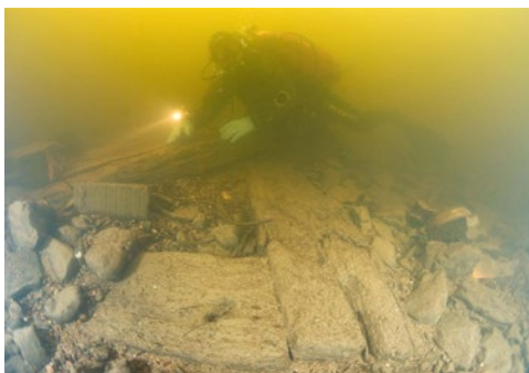
Torzo dřevěného základového roštu jednoho z pilířů Juditina mostu objevený potápěči Poříčího oddílu Policie ČR. Foto P. Slezák, 2010. © Kapr Divers
