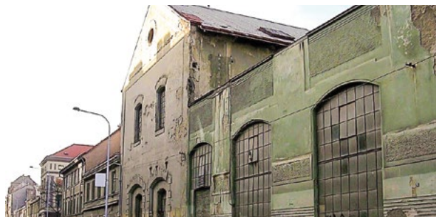
Továrna Breitfeld & Daněk v Pernerově ulici v Praze před rekonstrukcí
