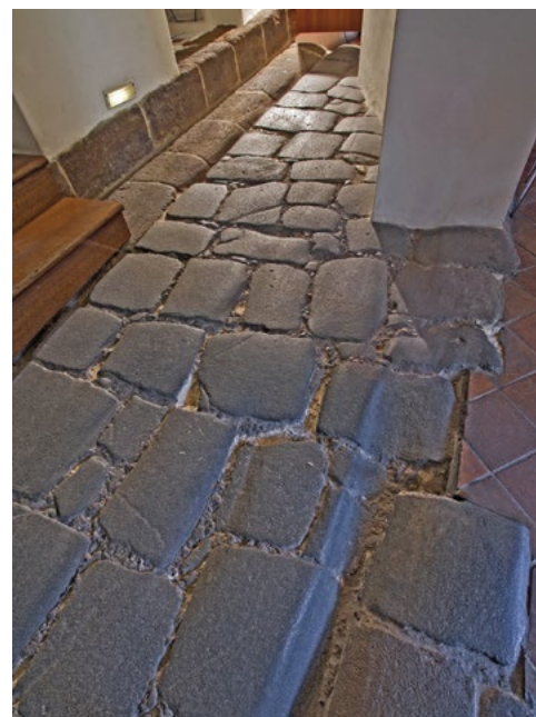
Druhá a nová vrstva povrchu Juditina mostu v přízemí domu č. p. 77 z tvrdých diabasových kamenů. Foto M. Frouz, 2007 © Národní památkový ústav, územní odborné pracoviště v Praze
