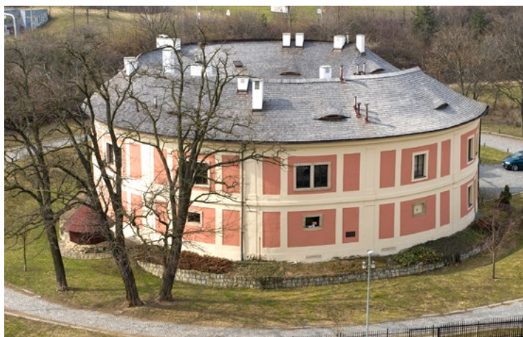
Chodovská tvrz z nadhledu v pohledu od východu. Foto L. Kovář, 2011
