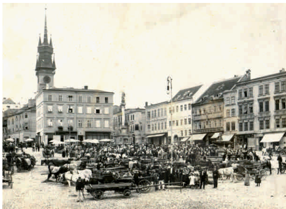
Pohled na trh na Masarykově náměstí před rokem 1918. V pozadí Mariánský morový sloup, radniční věž, ústí ulic Obroková a Zelinářská.
