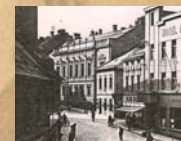
Oberleithnerův palác II (Gen. Svobody 6) Oberleithner's palace Oberleithner Palast
