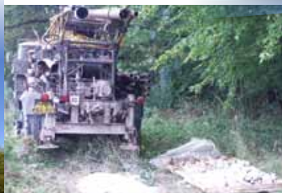
Vrtná souprava na vrtu „U Laviček“ při západním úpatí Paláce.
