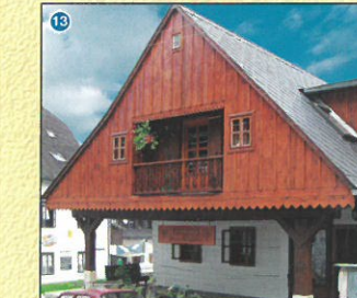
Roubený dům čp. 81 s pavlačou ve štítě pochází z konce 18. století. V přízemí se nachází květinárství.
