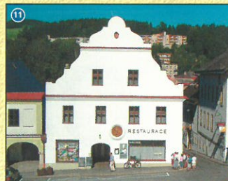
Charakteristiku zástavby náměstí vyjadřuje dům čp. 32 s barokním štítem, postavený kolem roku 1850. bývalý pivovar. Nyní je zde restaurace „U Vorlíčků“.
