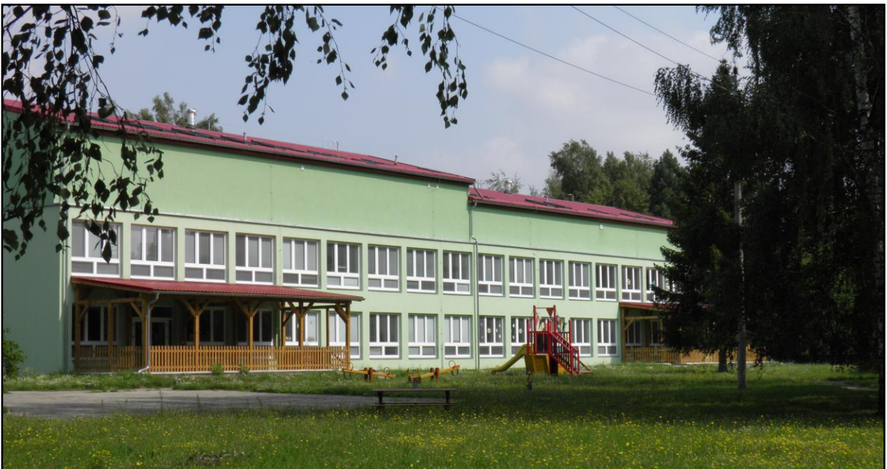
budova odloučeného pracoviště mateřské školy na ulici Poštovní
