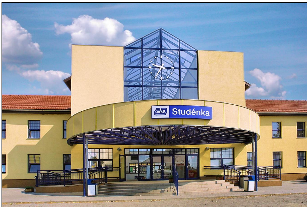
budova železniční stanice ve Studénce
