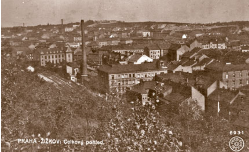
Žižkov kolem roku 1920, v popředí komín slavné žižkovské elektrárny založené Františkem Křížkem
